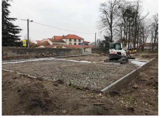
Pose des bordures de délimitation du terrain et du géotextile
