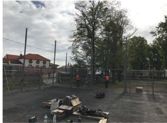
Réalisation de la plateforme en enrobé et pose de la structure du terrain multisports
