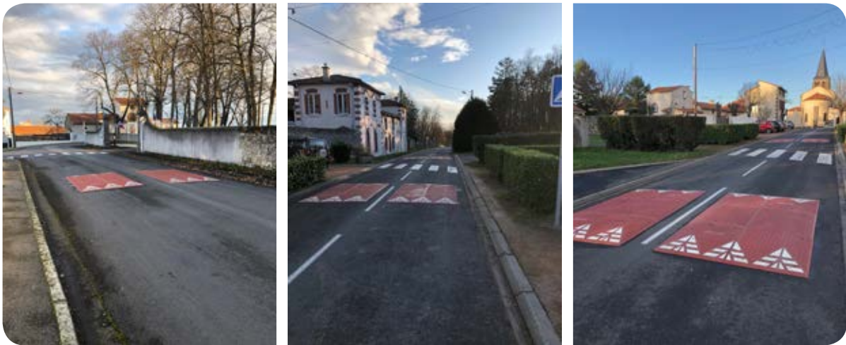
Installation de coussins berlinois et création de passages piétons, avenue du Château de Villeneuve et avenue St Roch
