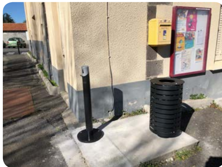
Installation de poubelles et de cendriers place et rue de l'école
